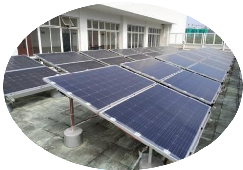
學校天台安裝 太陽能光伏板
